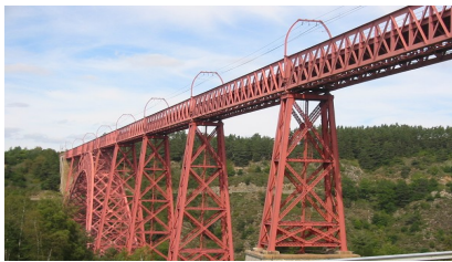
Viaduc de Garabit, un pont en arc métallique Gustave Eiffel (1884)
