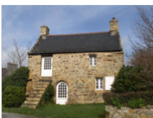
Maison bretonne avec son toit en ardoise, mur en pierre de granite.
