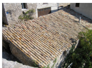
Toit niçois en tuile d'argile.
